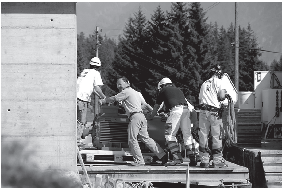
Nach der Anlieferung per Helikopter wird der Maschinensatz in die Zentrale geschoben. [EWA]
