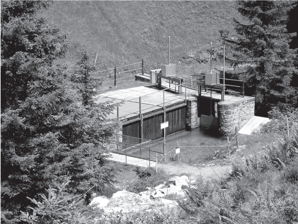
Unauffällige Triebwasserfassung am Leitschachbach [EWA]
