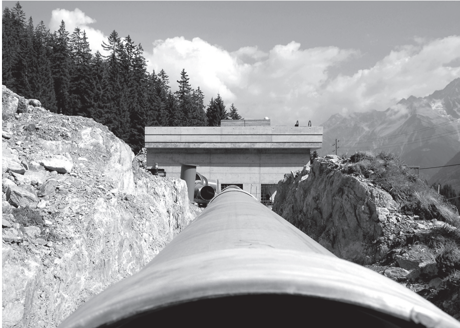
Die 156 m lange Druckleitung wurde mit GFK-Rohren erstellt. [EWA]
