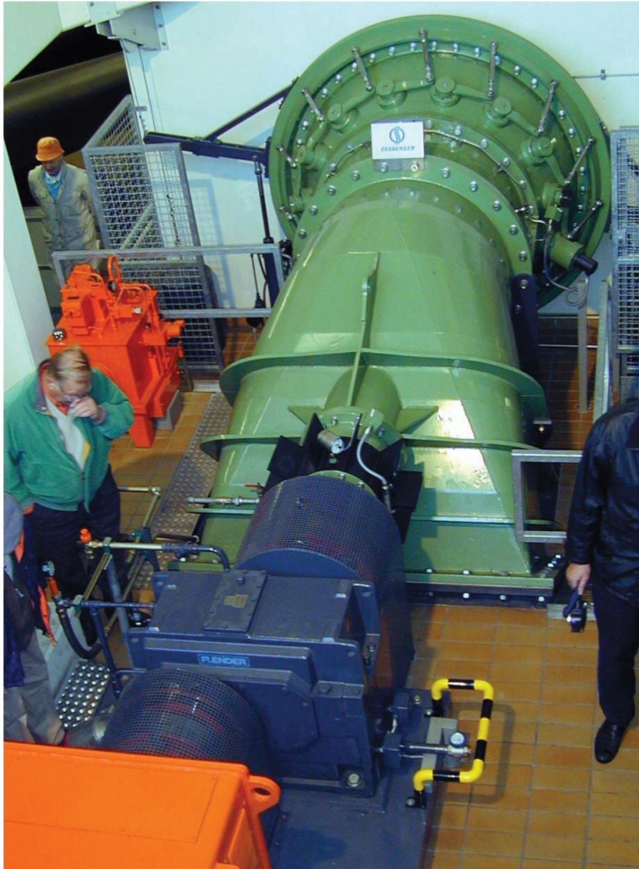
Bild 6 S-Turbine am Rothsee
